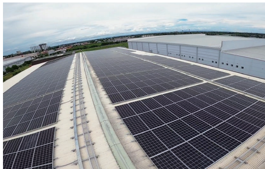
セブ工場での太陽光パネルの設置
