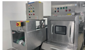
食堂設置/節水食器洗浄機の導入
